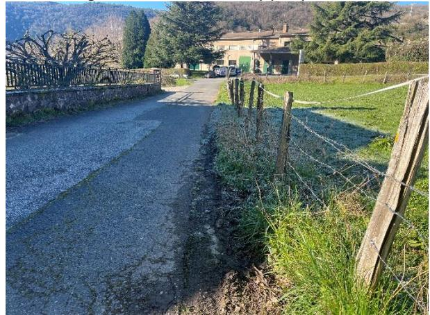
Fotografía 4 Cuneta inservible, asfalto dañado
