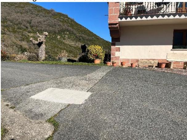
Fotografía 5 Zanja y reparación de bache
