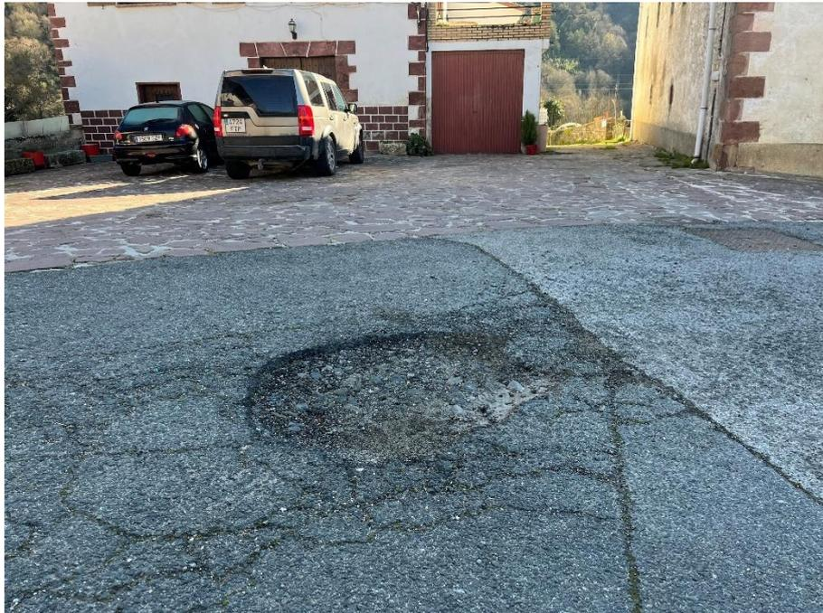
Este tipo de baches hacen que el pavimento se vaya despegando y aceleran la rotura de la plataforma.
