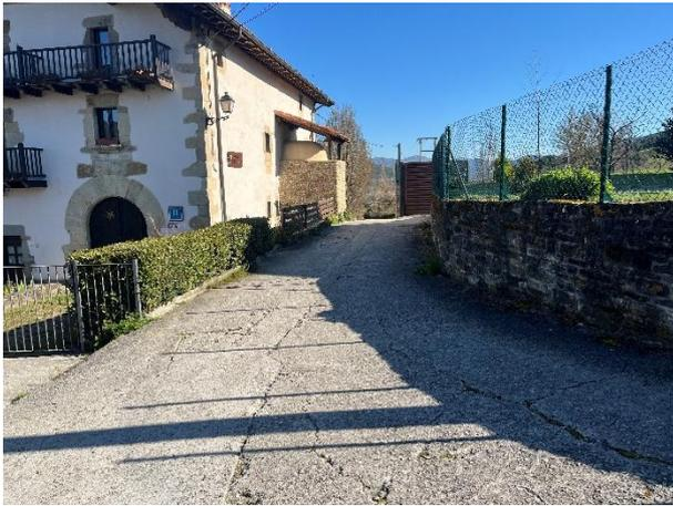
Fotografía 7 Pavimento dañado por zanjas
