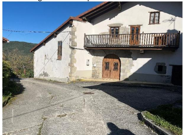
Fotografía 4 Pavimento atravesado por zanjas
