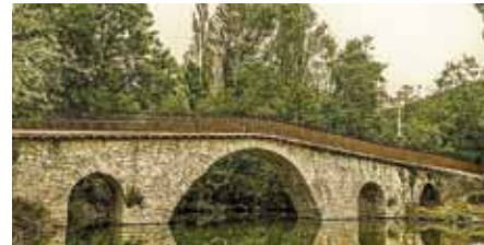
El puente románico de Iturgaiz en Irotz ya restaurado
