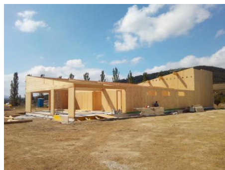
Fotos de las obras en ejecución (foto 2 y 3)
